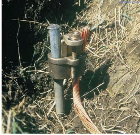
Resim 2.3: Topraklama çubuğuna topraklama iletkeninin bağlanması
