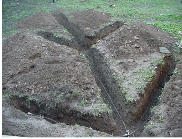
Resim 2.2: Kaz ayağı topraklama sistemi
