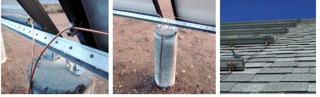
Resim 1.7: Açık alanlarda ve yapılarda güneş panellerinin topraklanması
