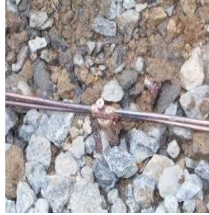
Resim 2.3: Topraklama çubuğuna topraklama iletkeninin bağlanması
