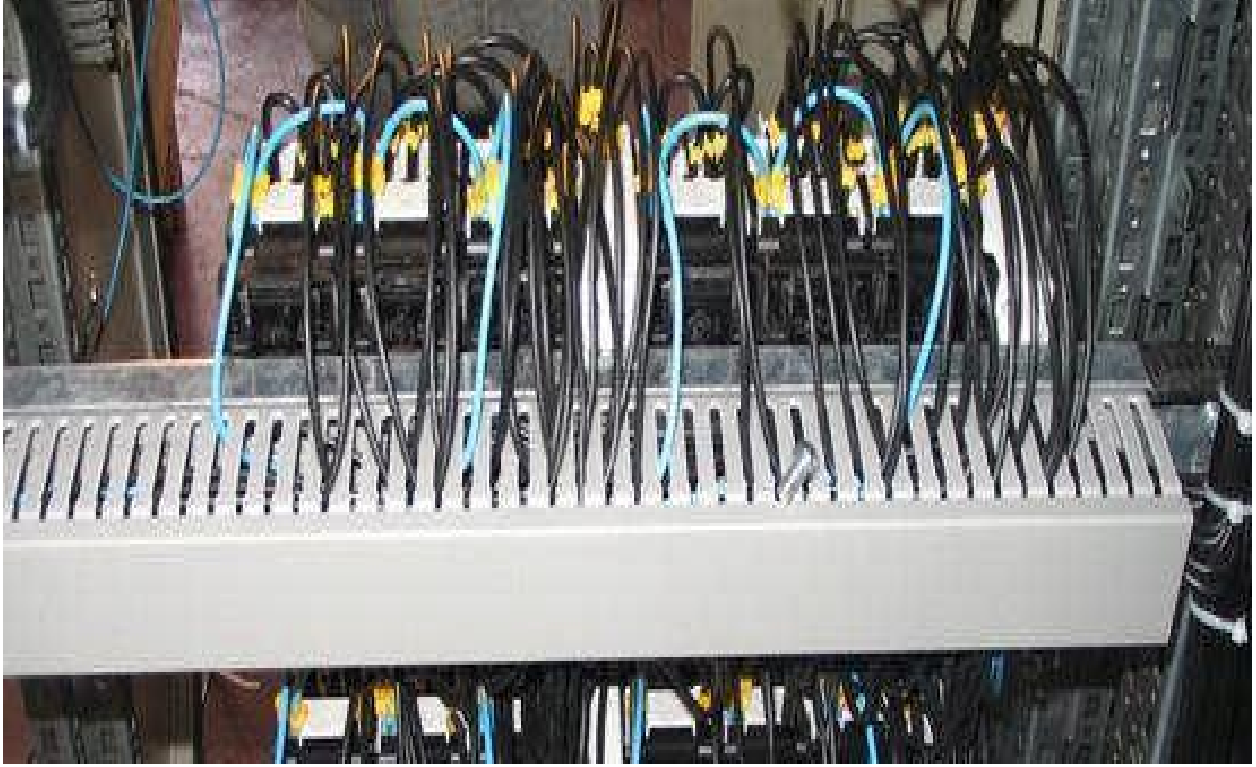
Resim 2.8: Kanal içine yerleştirilme işlemi tamamlanmış kablolar
