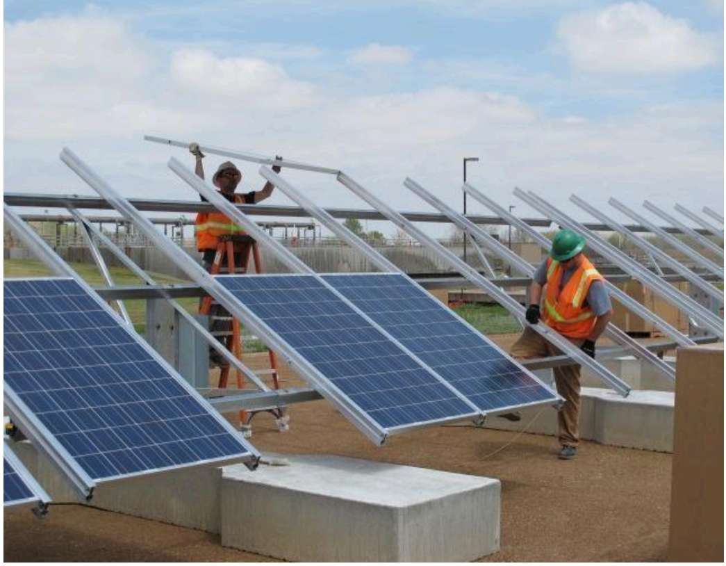
Resim1.2:Güneş sehpası montajı
