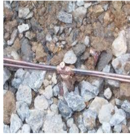
Resim 2.3: Topraklama çubuğuna topraklama iletkeninin bağlanması
