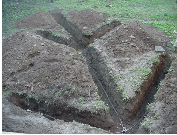
Resim 2.2: Kaz ayağı topraklama sistemi
