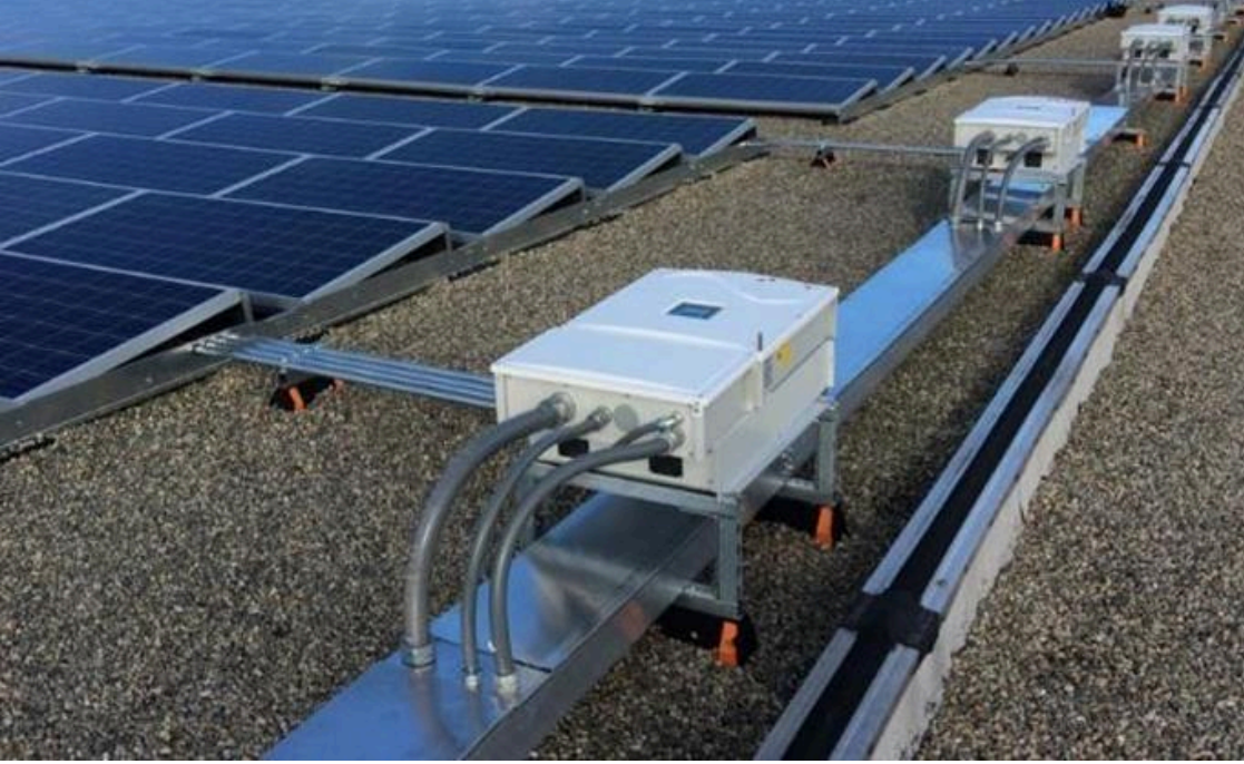
Resim 2.1: Panolar arası kablo montajı
