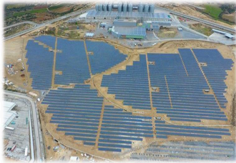
Resim 4.7: Açık alanda güneş paneli kurulumu
