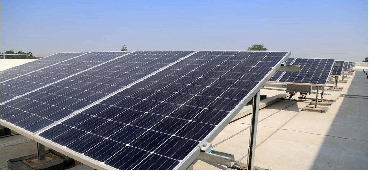
Resim 1.2: Düz çatı üzerine yapılmış panel montajı
