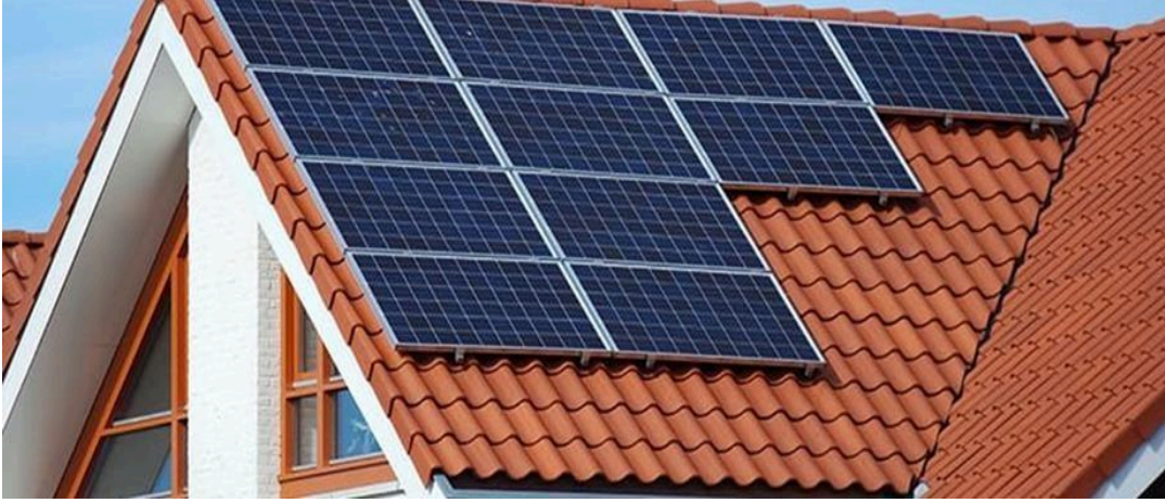
Resim 1.1: Güneye doğru bakan güneş panel sistemi
