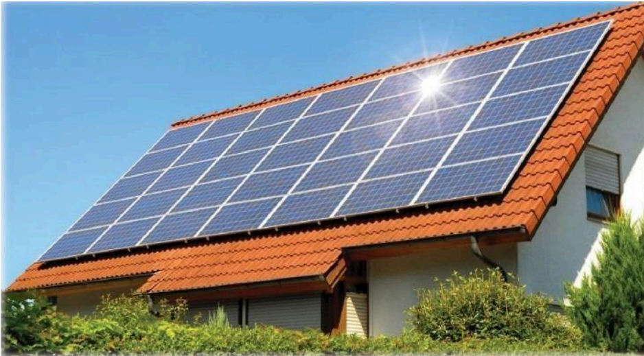
Resim 4.6: Açık alanda güneş paneli kurulumu
