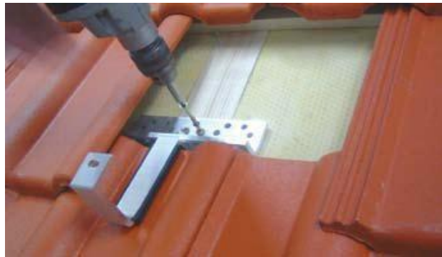
Resim 2.5: Kirişlerin üzerine çatı köşebendi montajı
