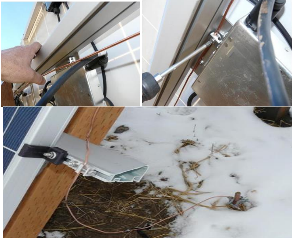
Resim 2.1: Metal taşıyıcı sistem ayaklarının topraklanması
