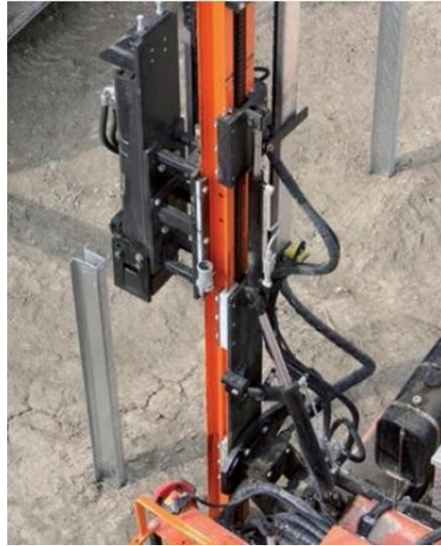
Resim 1.3:Güneş santrallerinde kullanılan çelik temel kazık ve çakma makinesi
