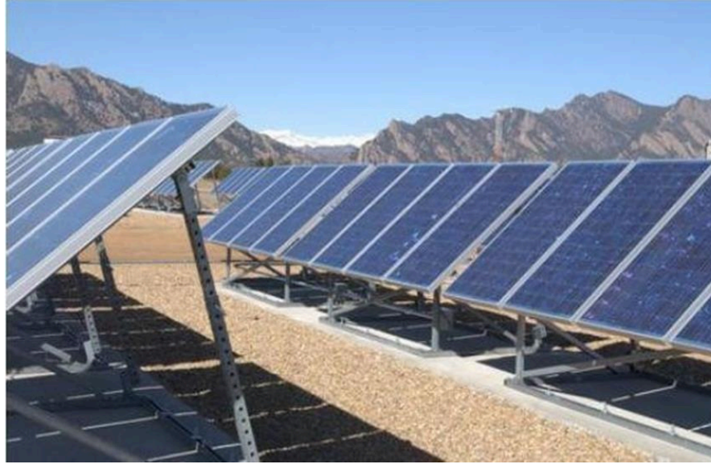
Resim1.5:Güneşpanelleriningüneşışınlarınıdikolacakşekildeeğimliyerleştirilmesi
