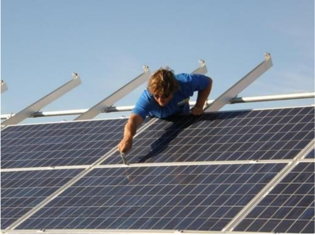
Şekil4.2.Güneşpanelininrayüzerinemontajelemanları
