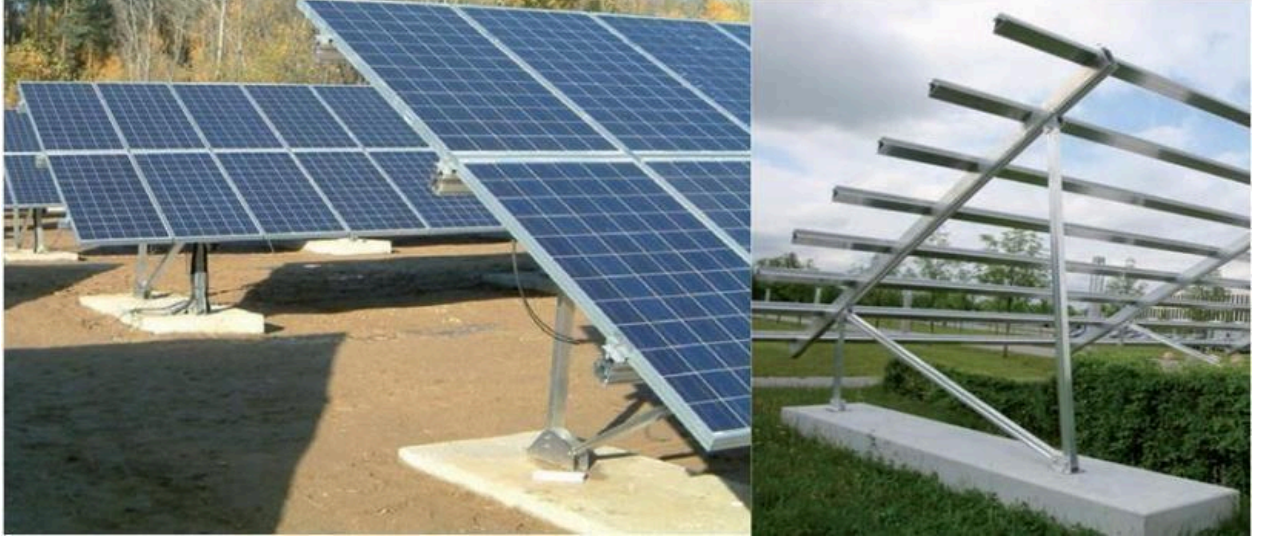
Resim 1.7: Metal taŐıyıcıların beton temellere bađlantı Őekilleri
