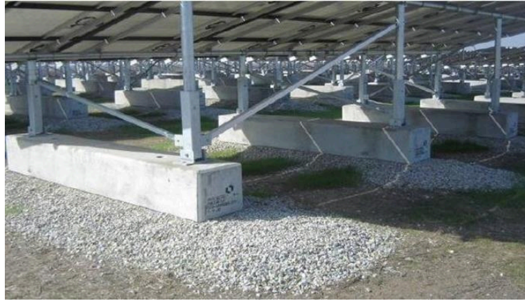
Resim 1.4: Güneş santralinde teraziye dengelenmiş metal taşıyıcı beton ve ankrajları
