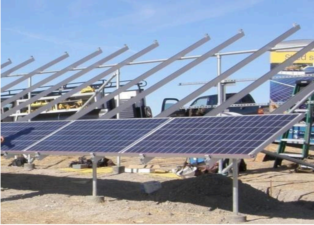
Resim 4.2: Güneş panellerinin profiller üzerine serilmiş hali
