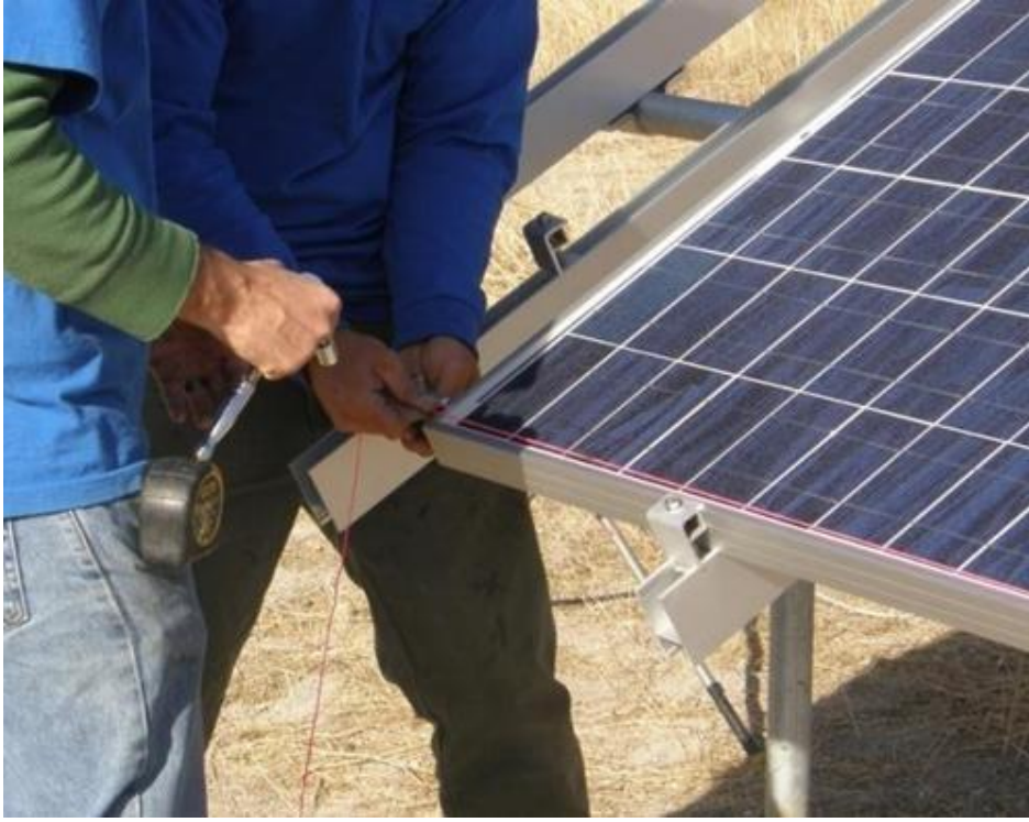
Resim 4.1:Güneş panellerinin dizilmesi esnasında aynı hizada tutulması
